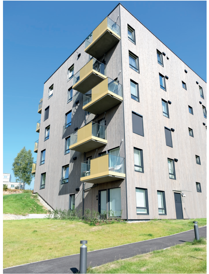
Fasaden er kledd med malmfuru.
